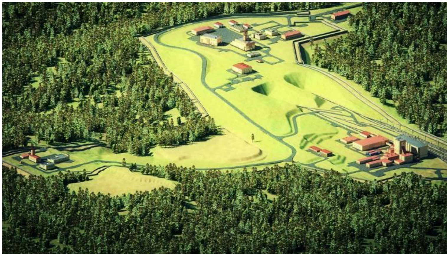
Рисунок 5. Общий вид Объекта
